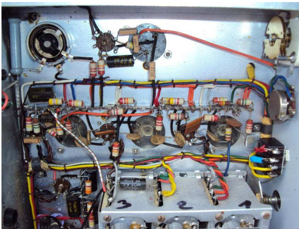
in evidenza il cablaggio rimesso a posto
